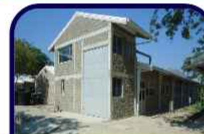
Laboratorio Integrado de Ingeniería Civil
